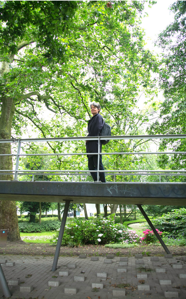
Deze brug verbindt het Museumplein en de Kunsthal. Om ongewenst gebruik eronder tegen te gaan – te weten slapende daklozen – zijn gelijmde bakstenen geplaatst.
